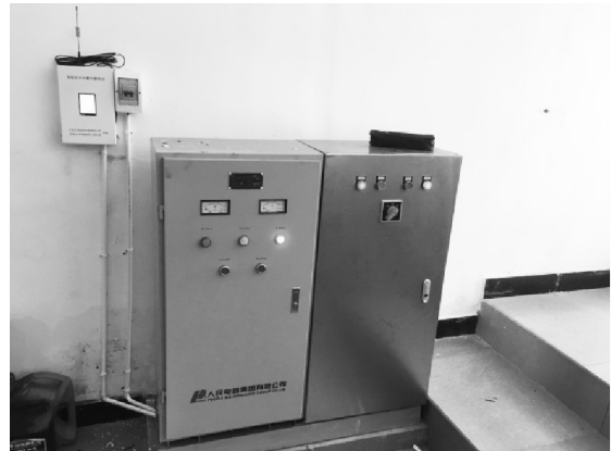
图7 监测设备现场安装示意图
