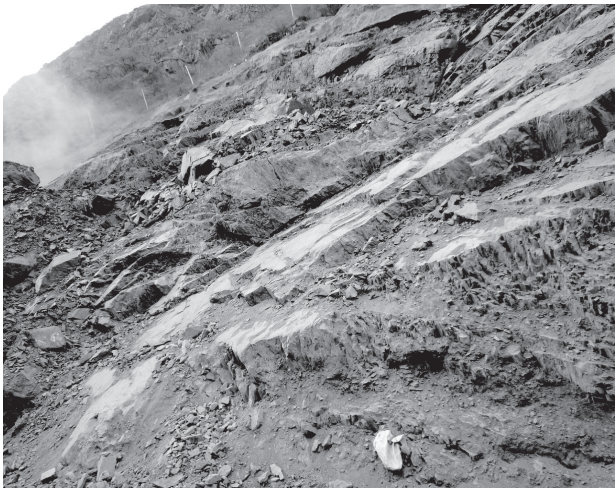
图 2 导流洞进口边坡岩石结构面
