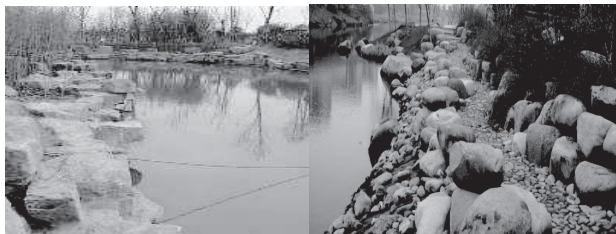
图 11 景观型山石护坡
