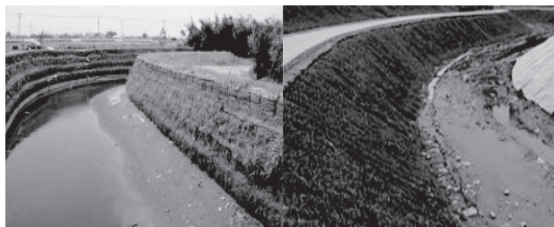
图9 植生卷材护坡
