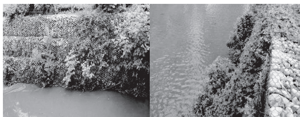
图7 净水石笼护坡
