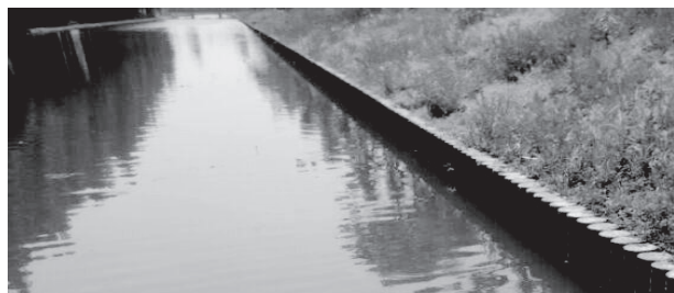
图1 木桩结合植物护坡
