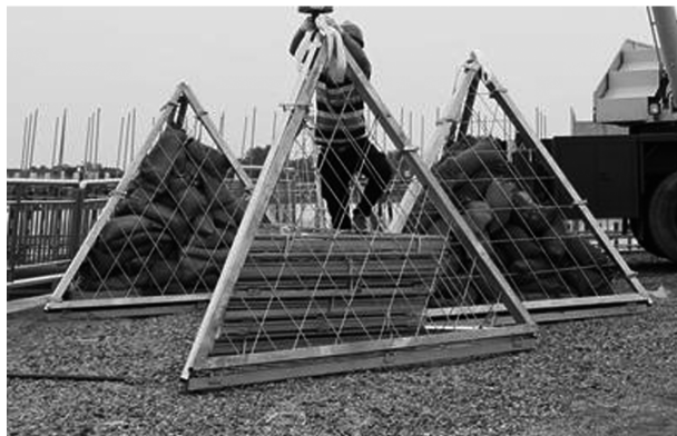
(b) 装填土袋、小型四面体结构外框的堵口装置
