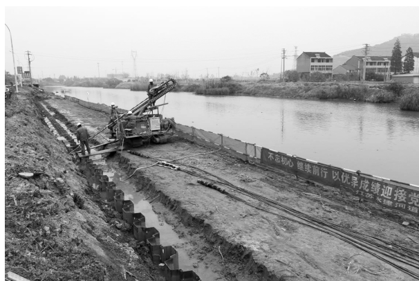
图4 囊式扩大头锚索施工现场实拍
