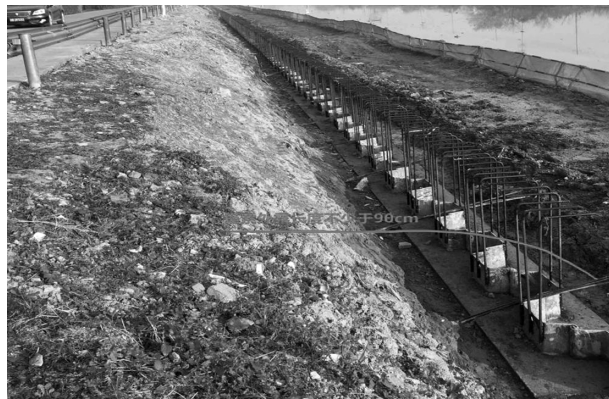
图6 锚索孔口外露位置
