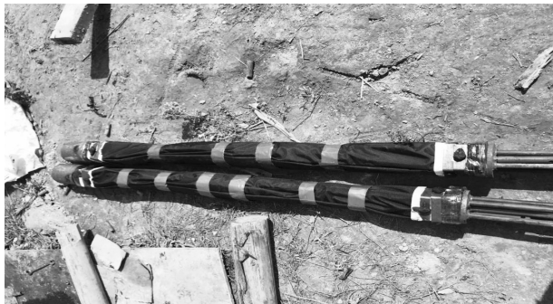
图5 制作好的囊式扩大头锚索
