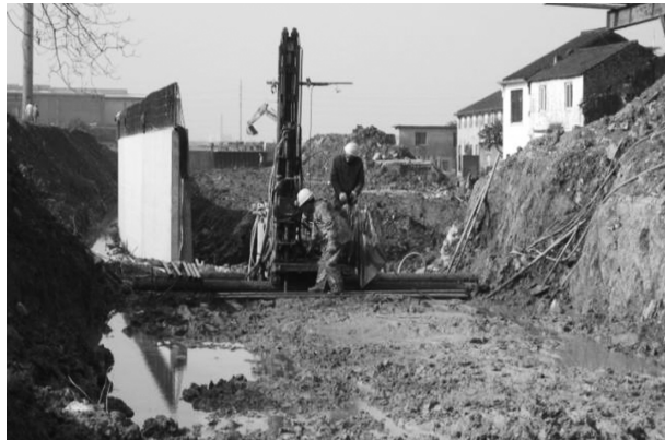
图5 高压旋喷桩现场施工图
