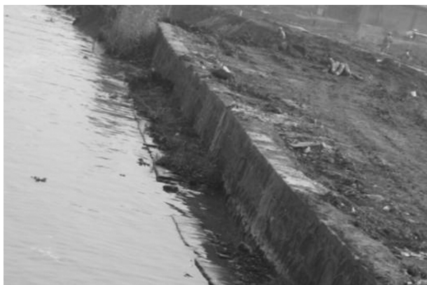
图1 2.6 m水位时露出的二级驳岸现状图
