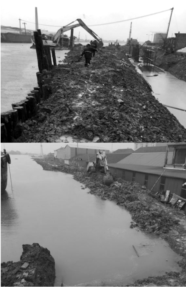
图3 460型挖机水下取土加高堤防
