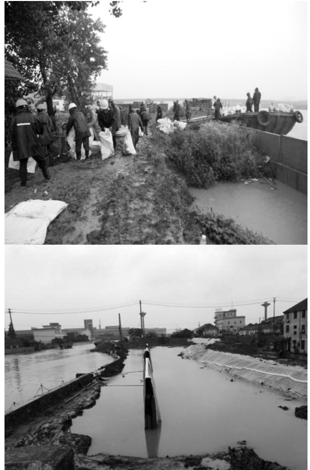
图4 协助地方政府抢险装运土方构筑第二条防线梳理。
