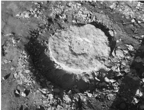
图 1 现场试桩桩头情况
