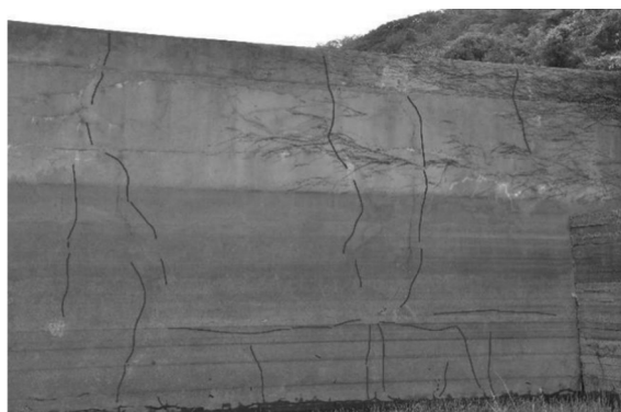
图2 副坝右岸坝段上游面裂缝分布
