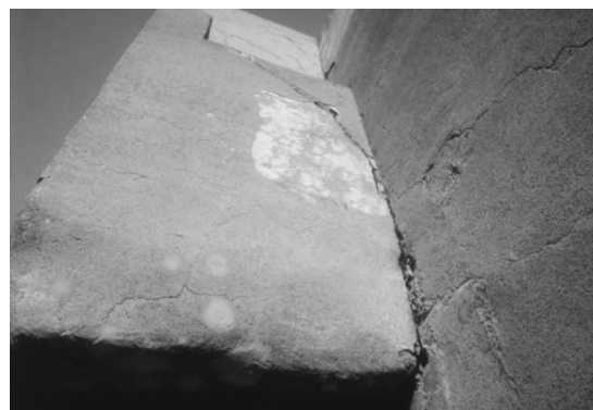
图5 主副坝交界处结构缝
