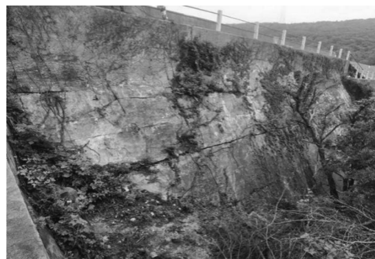
图3 主副坝交界处表面裂缝
