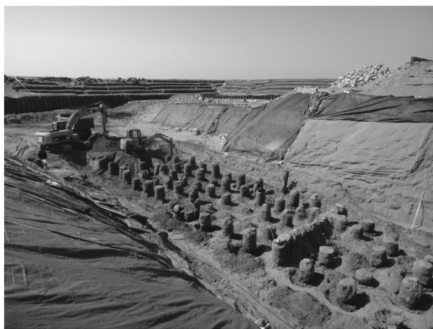
图3 MC劲性复合群桩开挖实景
