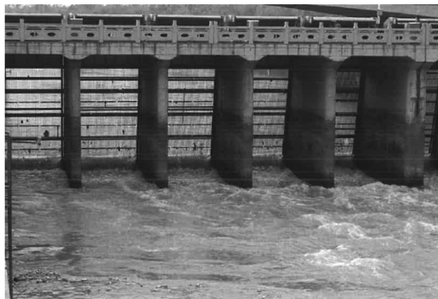
图1 九圩港闸站枢纽工程所属拦污栅结构
